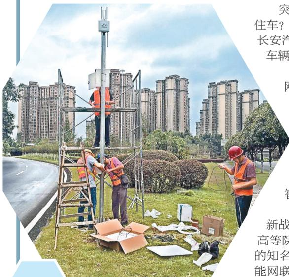
技术人员正在安装中汽院智能网联科技有限公司研发的路侧RSU通信设备。
