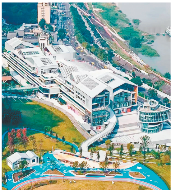
▲三洞桥PARK项目一景。 ▲三洞桥PARK项目全景。
