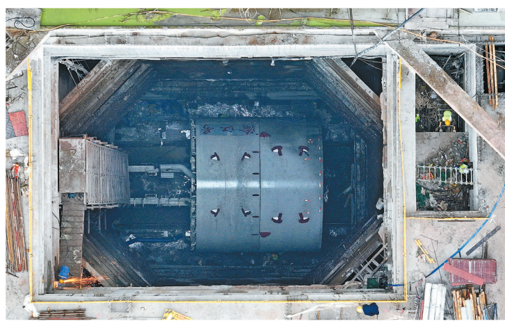
图为,中铁一局的技术人员正在井下调试设备。 ▼图为,巨型盾构机正在井下完成组装工作。
