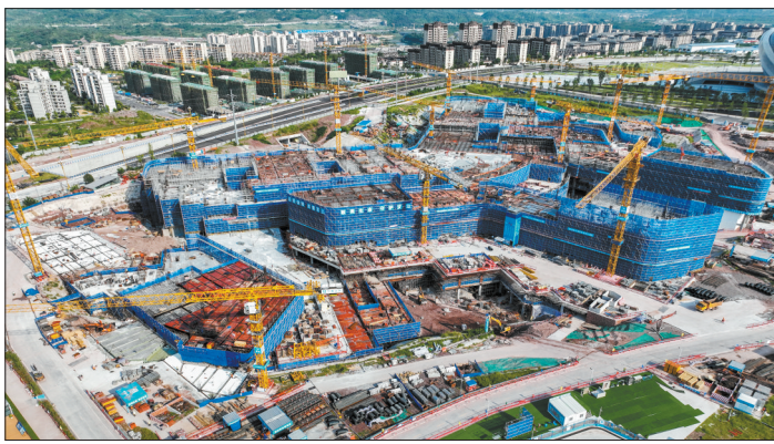
武汉协和重庆医院建设现场。(重庆两江国际体育文化产业园投资有限公司供图)
