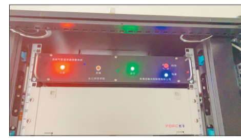
页岩气管道泄漏预警系统设备。
