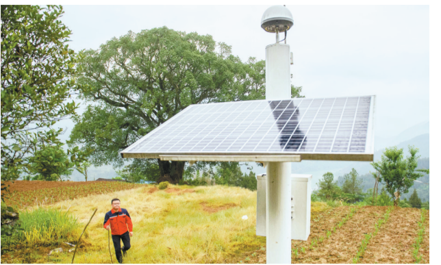
5月9日，武隆区江口镇黄草村，驻守地质工程师正在陡磊子滑坡变形区内查看GNSS地表位移监测设备运行情况。重庆日报记者 张锦辉 摄
