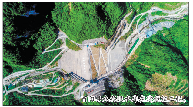
酉阳县九龙眼水库在建枢纽工程。
