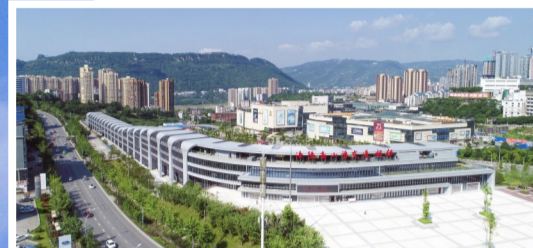
▲涪陵高山湾综合客运换乘枢纽及附属设施工程,荣获“中国建设工程鲁班奖”。
