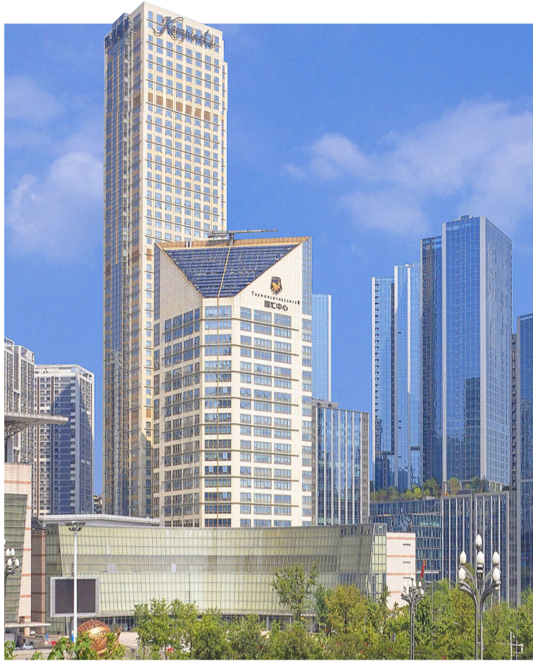
国汇中心——荣获“中国土木工程詹天佑奖”“国家优质工程奖”。
