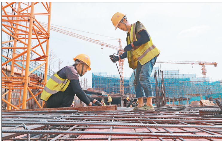
八月二十九日,西部(重庆)科学城AI CITY建设现场,工人正在加紧施工。 重庆日报记者 龙帆 实习生 尹诗语 摄
