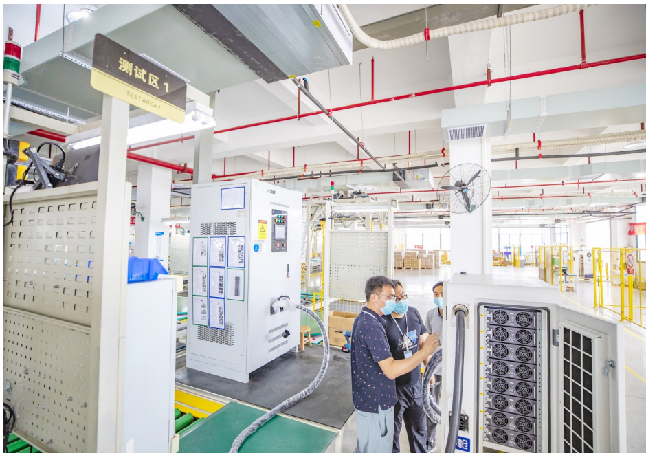
近日,在重庆惠程未来智能电气有限公司生产车间内,工作人员对生产好的充电桩进行通电测试。 新华社记者 黄伟 摄
