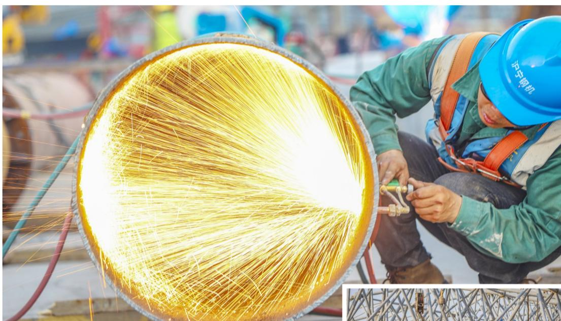
近日,在中建八局承建的重庆江北国际机场T3B项目施工现场,施工人员对钢结构材料进行切割。
