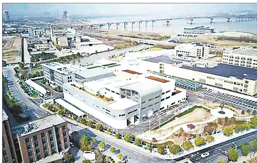
耐德新明和承接的杭州垃圾环保综合体项目。
