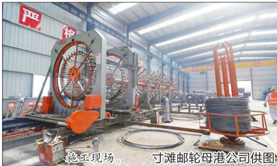
施工现场。寸滩邮轮母港公司供图
