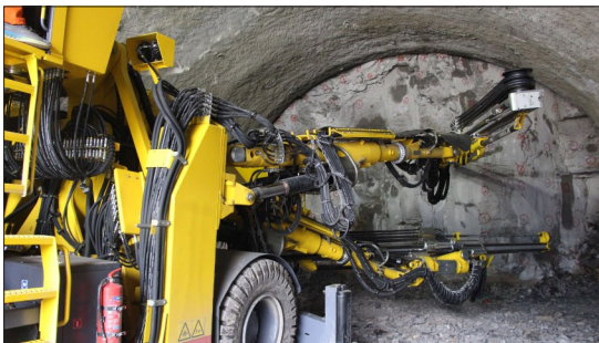
隧道机械化施工。
