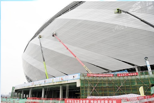
工人正在安装足球场外立面。通讯员 蓝天 摄
