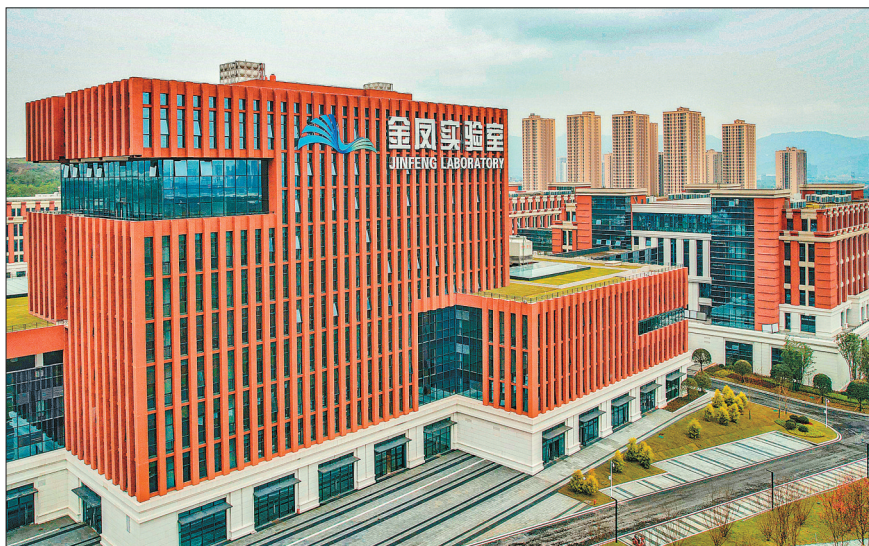
西部(重庆)科学城,建设中的金凤实验室。
