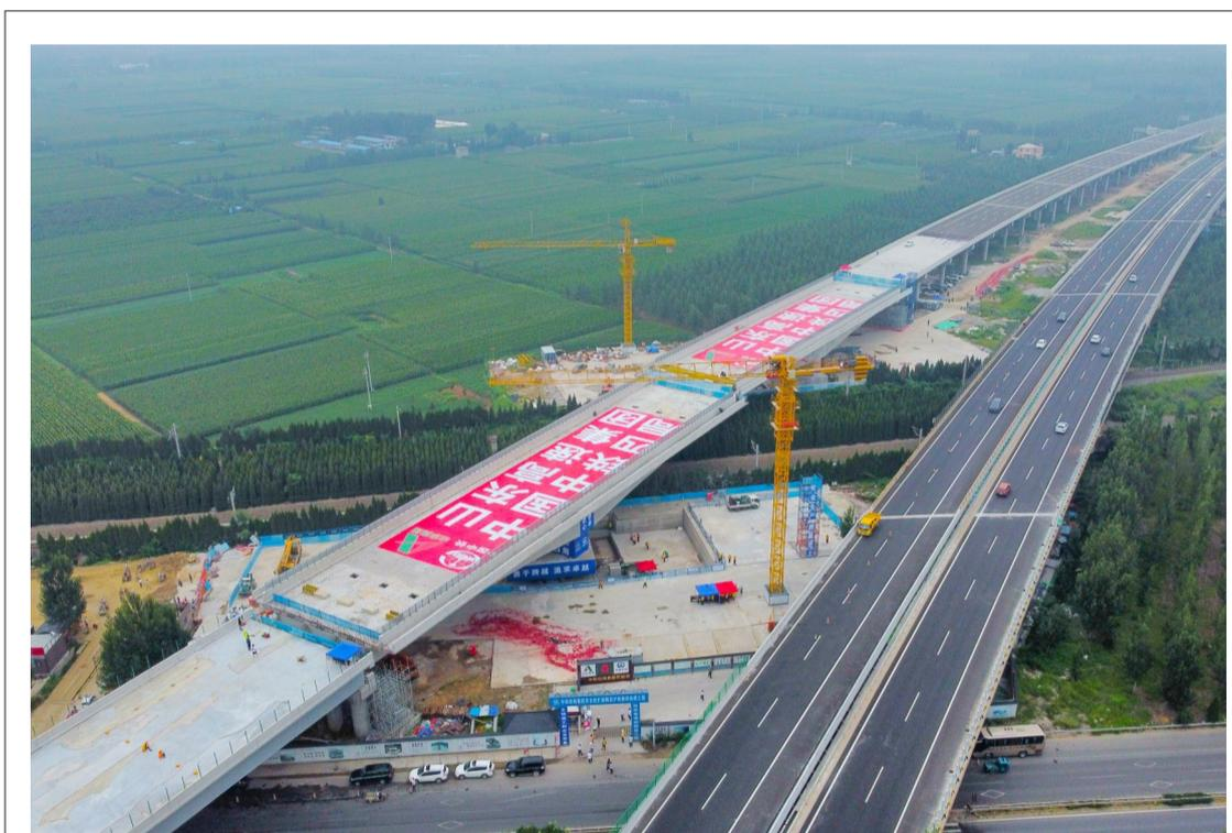
跨京沪铁路双T构转体桥顺利完成双转体施工(无人机拍摄)。
