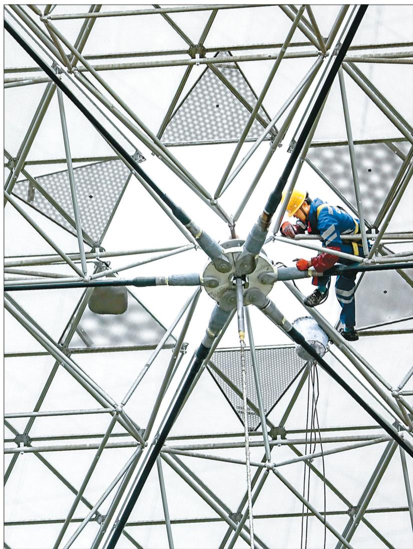
3月28日,工作人员对FAST反射面板进行常规维护。
