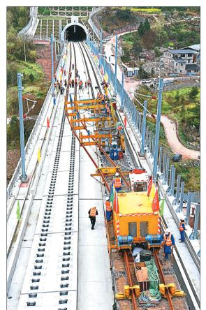
3月17日,BLCP500 型本邻两线长轨铺设机组 进行机械化跨线铺轨作
