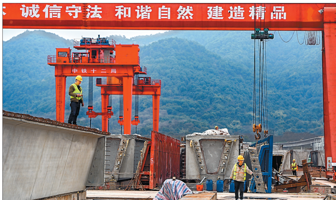
2月18日,西部(重庆)科学城,坪山大道一期施工现场,工作人员正在施工作业。
