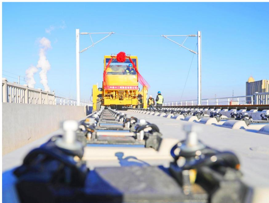
近日,中铁十二局工程技术人员操作轨道牵引车进行铺轨作业。在辽宁省朝阳市,由中铁十二局负责施工的朝凌客专无砟道床段落钢轨全线铺通,标志着朝凌高铁进入开通前的冲刺阶段。朝凌客专自朝阳市引出,经辽宁省朝阳市、北票市、锦州市后接入京哈铁路秦沈段(秦沈客专)的凌海南站,建设里程105.6公里,设计时速350公里,是我国东北地区高速铁路网的重要组成部分。
