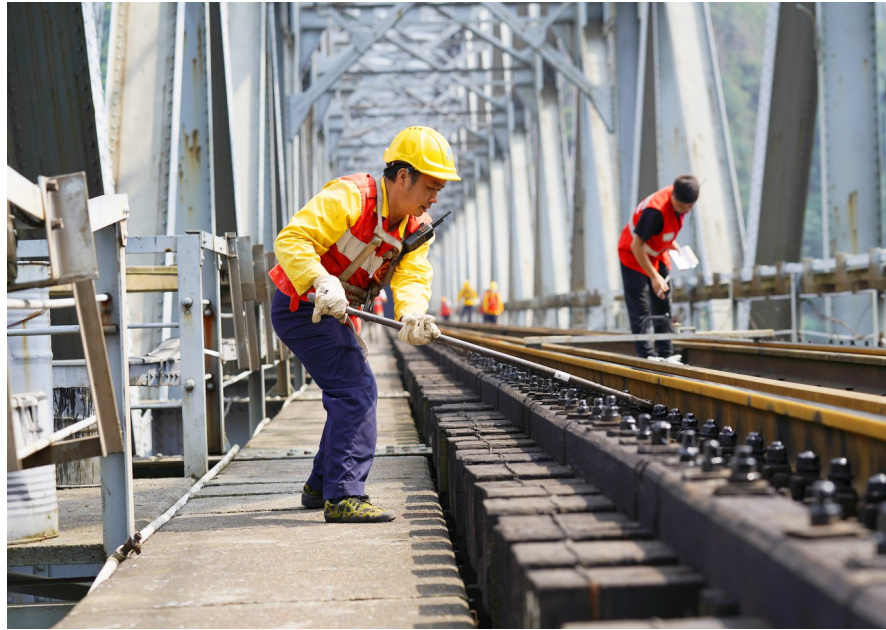
位于重庆北碚的嘉陵江铁路钢梁大桥,是襄渝铁路的咽喉要道,是一座全木枕结构的钢梁桥。汛期,中国铁路成都局集团有限公司重庆工电段北碚桥路检查工区的养护工人加大对桥梁的检查、维护力度,保证铁路的安全运行。 新华社 秦廷富 摄
