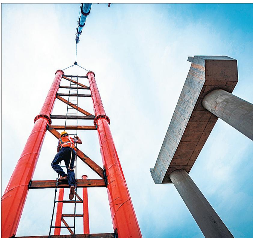
日前,大足区大内高速黄桥枢纽互通施工现场,工人正在进行钢箱梁临时支架吊装作业。
