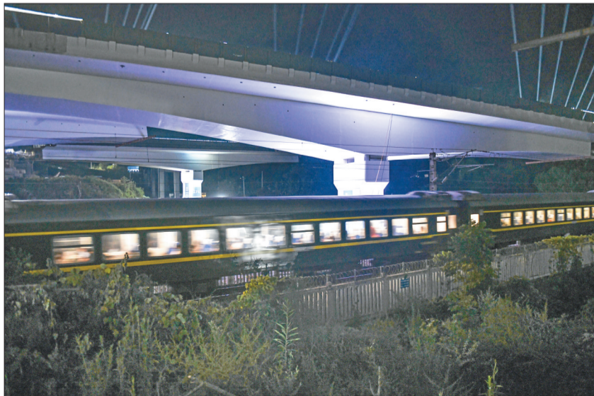
8月21日凌晨1点,重庆市快速路二横线西段项目跨渭井、蔡歌铁路线主线桥,实现“五桥同转”。图为列车从转身过程中的五桥驶过。
