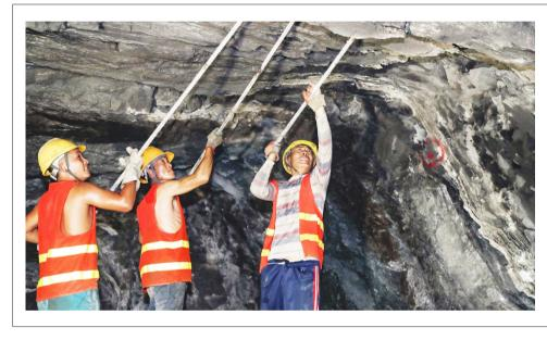
近日,施工人员在 中建五局承建的重庆轨 道交通9号线一期工程 土建一标段进行掌子面 人工排危作业。
