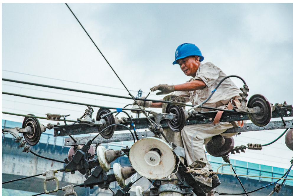
▲抢修线路。重庆市轨道交通(集团)有限公司 友铭 摄
