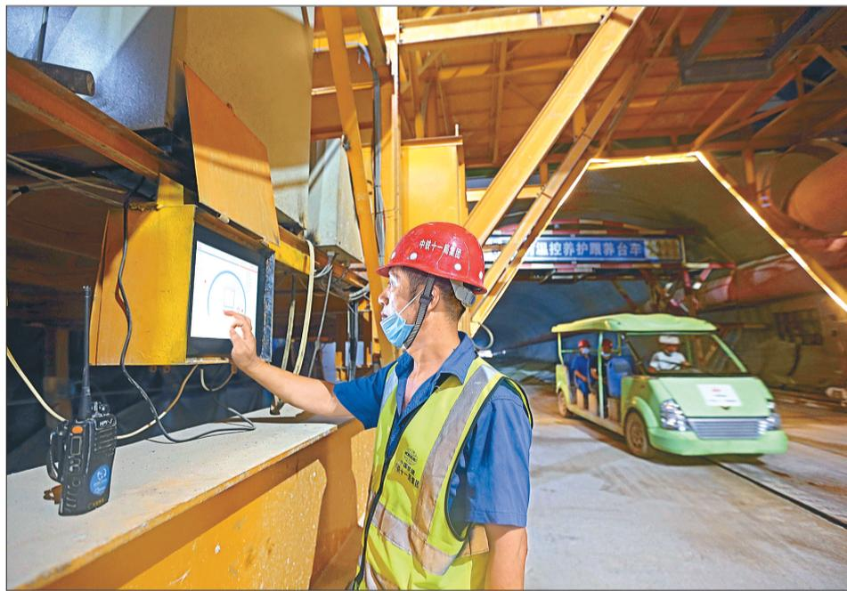
日前,建设中的合璧津高速九峰山隧道施工现场,技术员正在操作二衬数字化养护台车。
