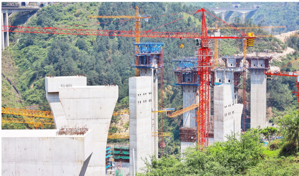
由中铁四局承建的重遵高速(重庆至遵义)扩容工程贵州段加紧施工,工程建设人员加班加点,力争把受影响的进度补回来。 新华社记者 刘续 摄
