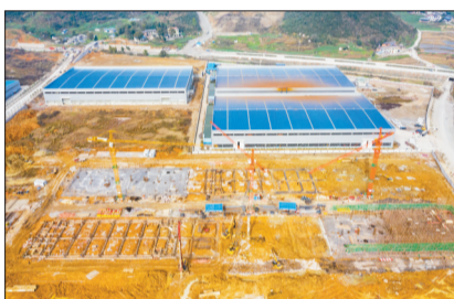
正在施工建设中的涌泉环保项目。
