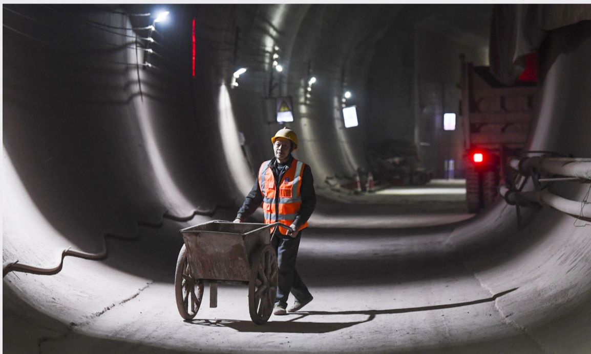
由中建三局三公司承建的重庆轨道交通九号线一期工程化龙桥站至李家坪站区间隧道右线近日顺利贯通,标志着该隧道全线贯通。重庆轨道交通九号线一期线路起于重庆沙坪坝区高滩岩,终点在渝北区回兴,全长约32.3公里,预计将于2020年建成通车。 新华社记者 王全超 摄
