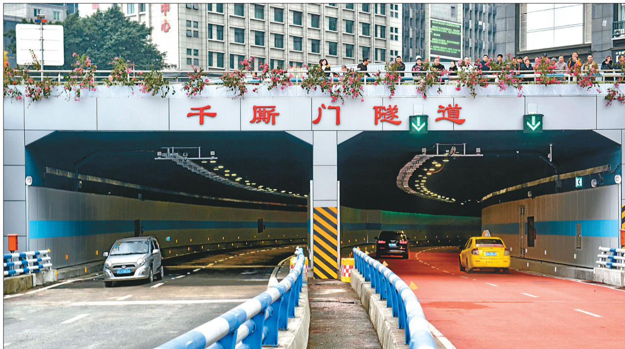
2019年12月31日,连接千厮门大桥和东水门大桥的千厮门隧道通车。
