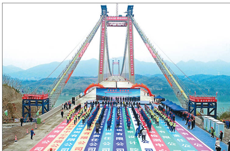
南两高速公路太洪长江特大桥顺利合龙。(受访者供图)
