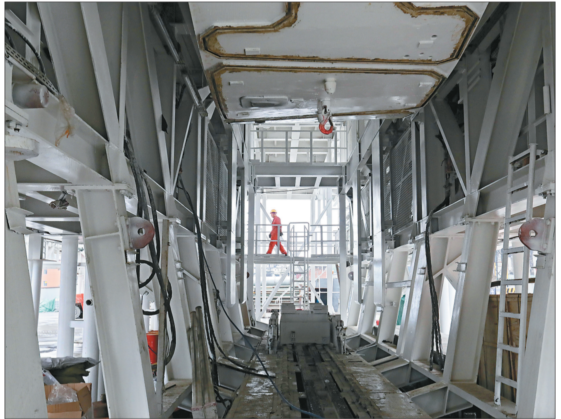
日前,中铁十四局的技术人员正在进行盾构机的调试工作。
