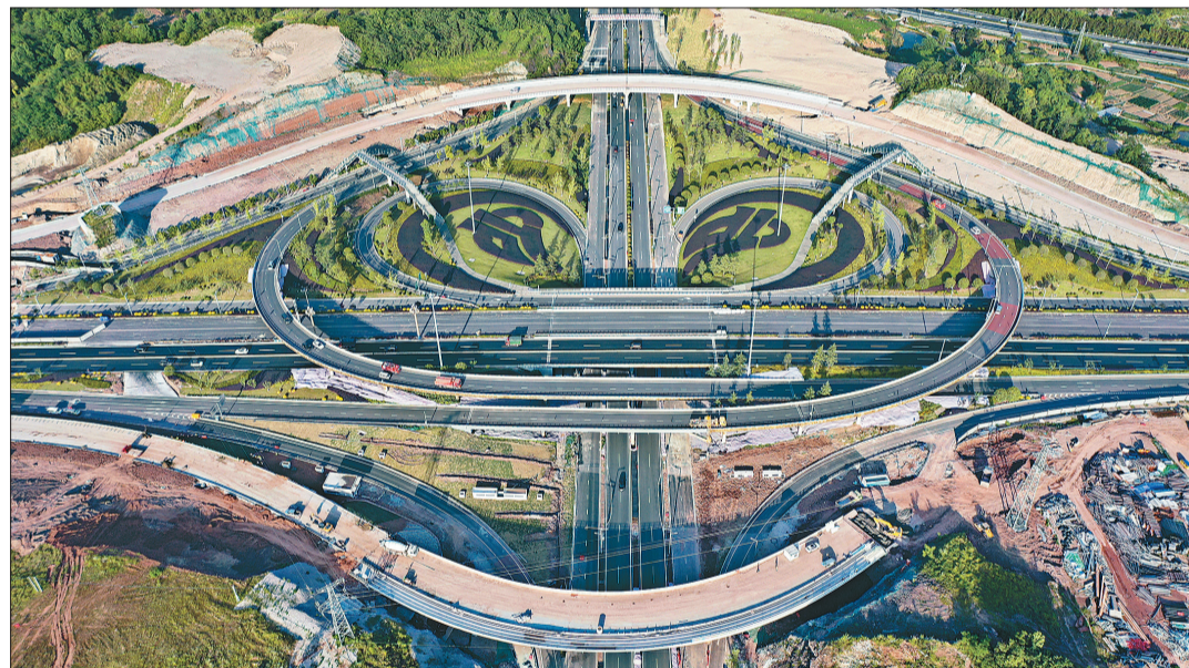
5月4日,西部(重庆)科学城科学大道一期青龙咀立交桥作业现场,工人正在加紧施工。 重庆日报记者 龙帆 摄
