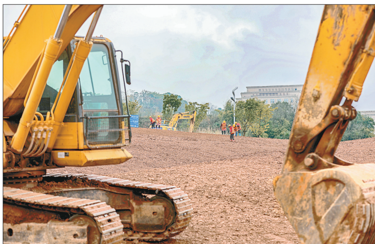
二月七日,西部(重庆)科学城高新大道,工人正在抓紧施工。重庆日报记者 龙帆 摄
