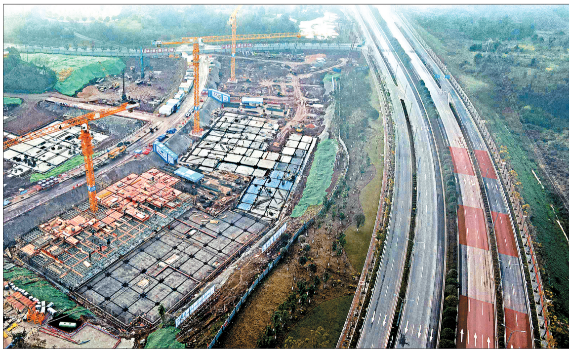
这是2021年1月1日拍摄的重庆两江协同创新区联合产业孵化基地项目施工作业现场(无人机照片)。据介绍,联合产业孵化基地项目以“开放共享、绿色自然、立体活力、多元混合、科技智慧”为核心设计
