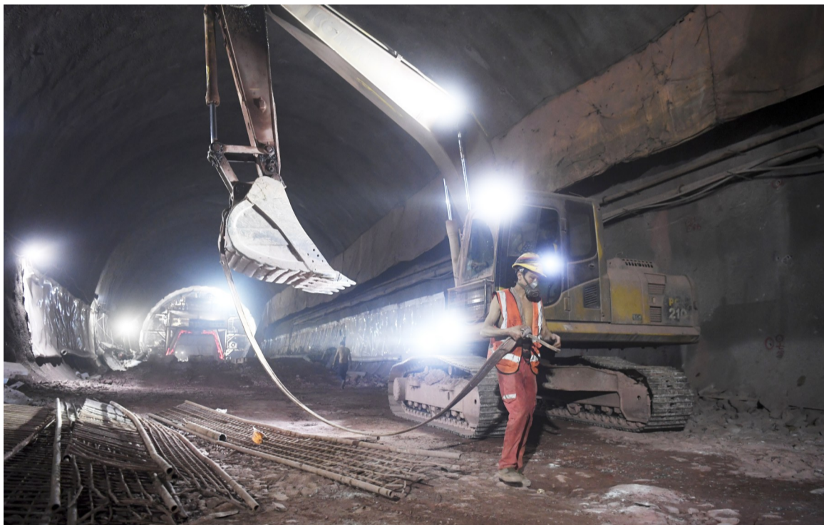
12月15日,工作人员在郑万高铁巫山隧道贯通面进行施工作业。当日,由中铁二院设计、中铁十八局承建的郑万高铁重庆段控制性工程巫山隧道顺利贯通。郑万高铁位于豫、鄂、渝三省市境内,是我国“八纵
