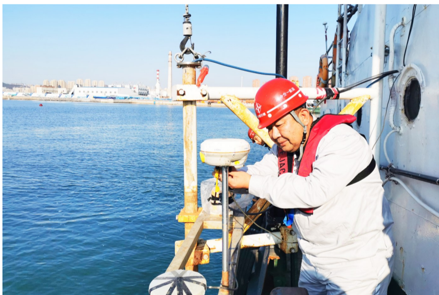
近日,在大连湾海底隧道建设工程现场,中交一航局第三工程有限公司测量首席技能专家陈兆海使用三维多波束测深系统进行测量。
