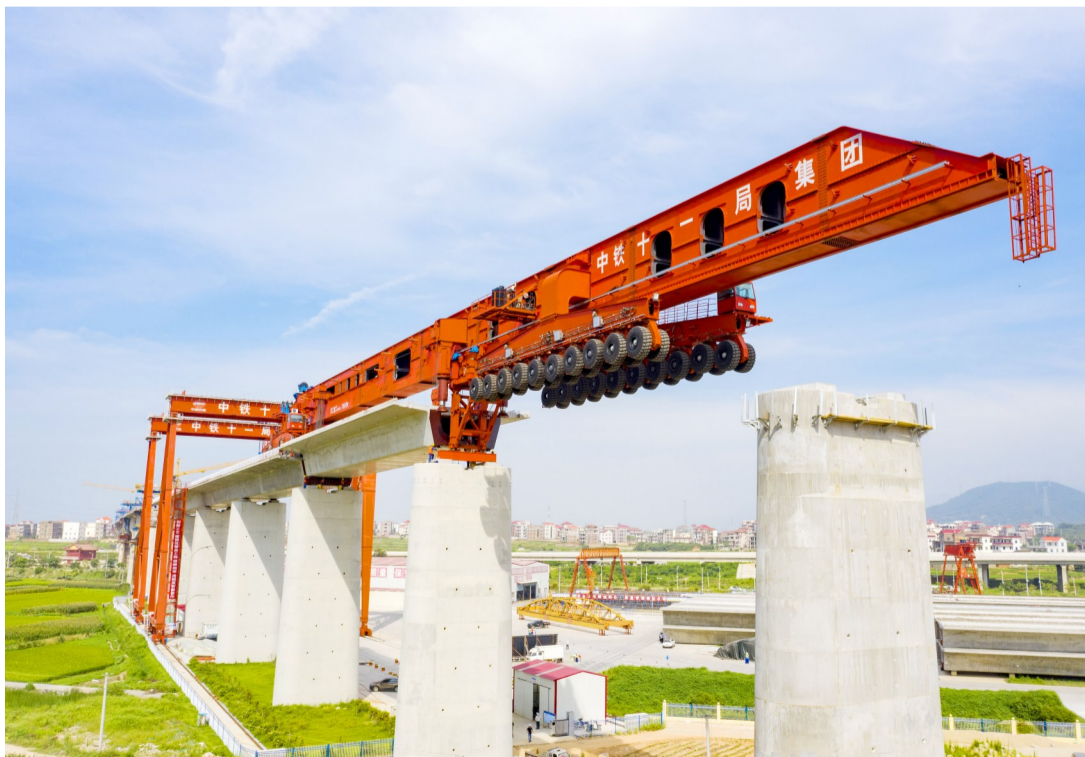
近日,在福厦高铁湄洲湾跨海大桥施工现场,高铁箱梁运架一体机在架设1000吨箱梁。
