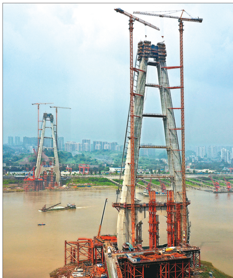
日前,主桥塔240米高的重庆白居寺长江大桥进入塔顶施工阶段。据了解,该桥是我市快速路“五横线”重要节点工程,计划2022年建成通车,届时从巴南到大渡口就有了一条便捷通道。 重庆日报特约摄影 钟志兵
