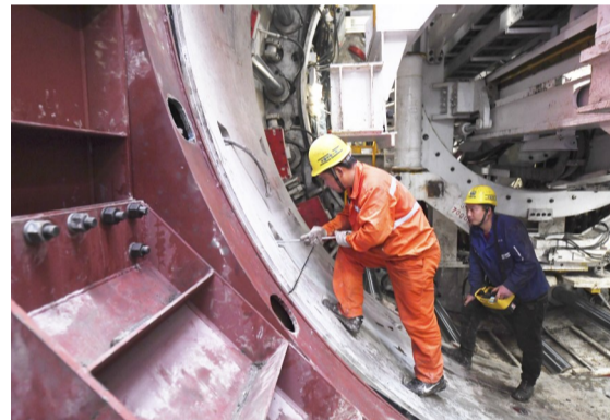
目前,重庆轨道交通四号线二期工程加紧施工。据悉,重庆轨道交通四号线二期线路全长约32.8公里,全线共设14座车站。图为施工人员在中铁一局承建的重庆轨道交通四号线二期工程土建5标段作业。
