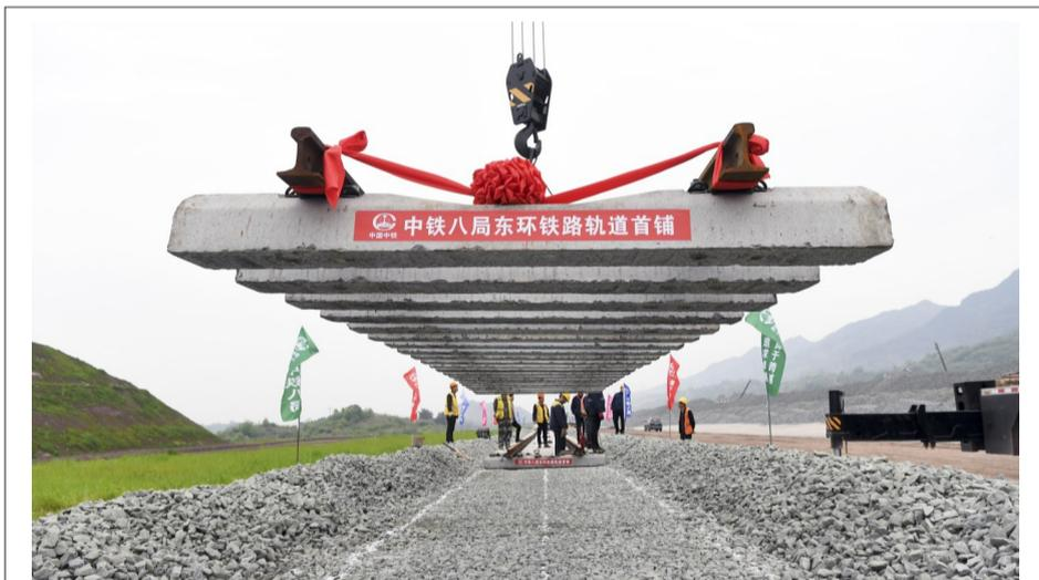
4月2日,重庆铁路枢纽东环线首组12.5米的轨排稳稳落在龙盛车站路基上,标志着重庆铁路枢纽东环线正式进入铺轨施工阶段。 新华社记者 唐突 摄
