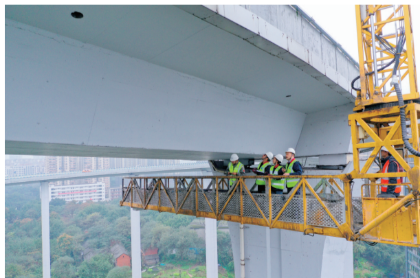
城投路桥员工在检修桥梁
