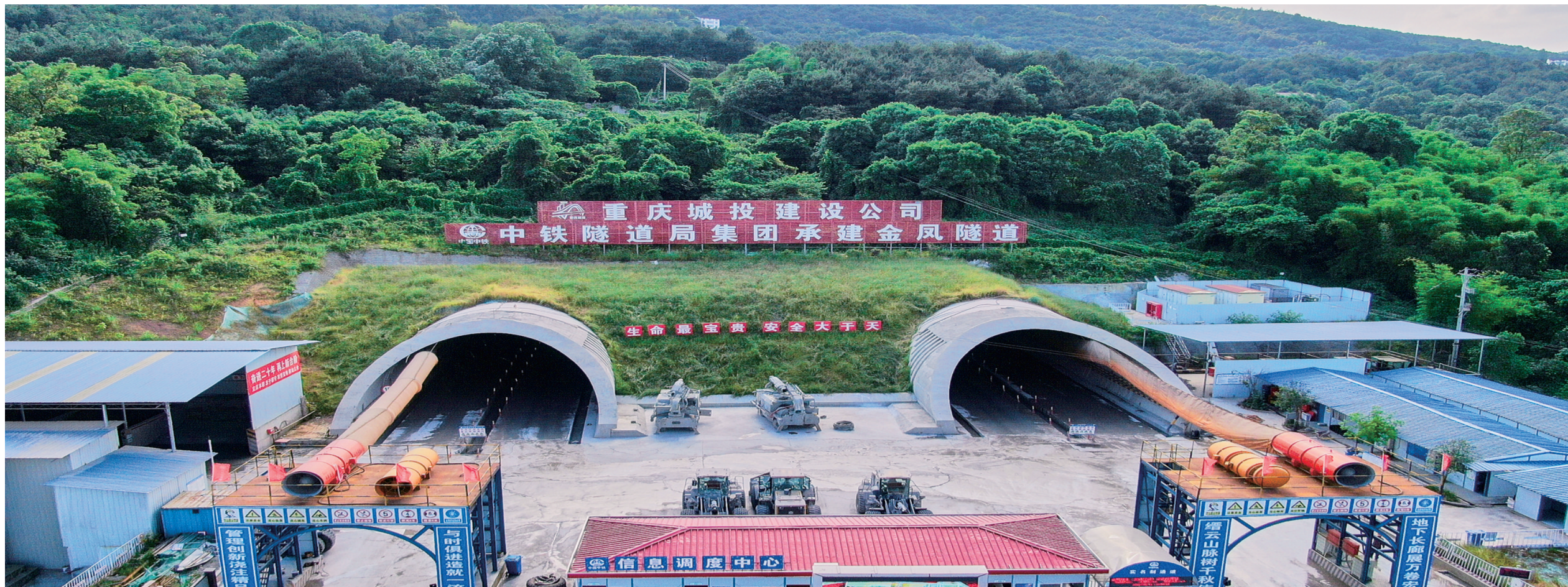
金凤隧道项目现场
