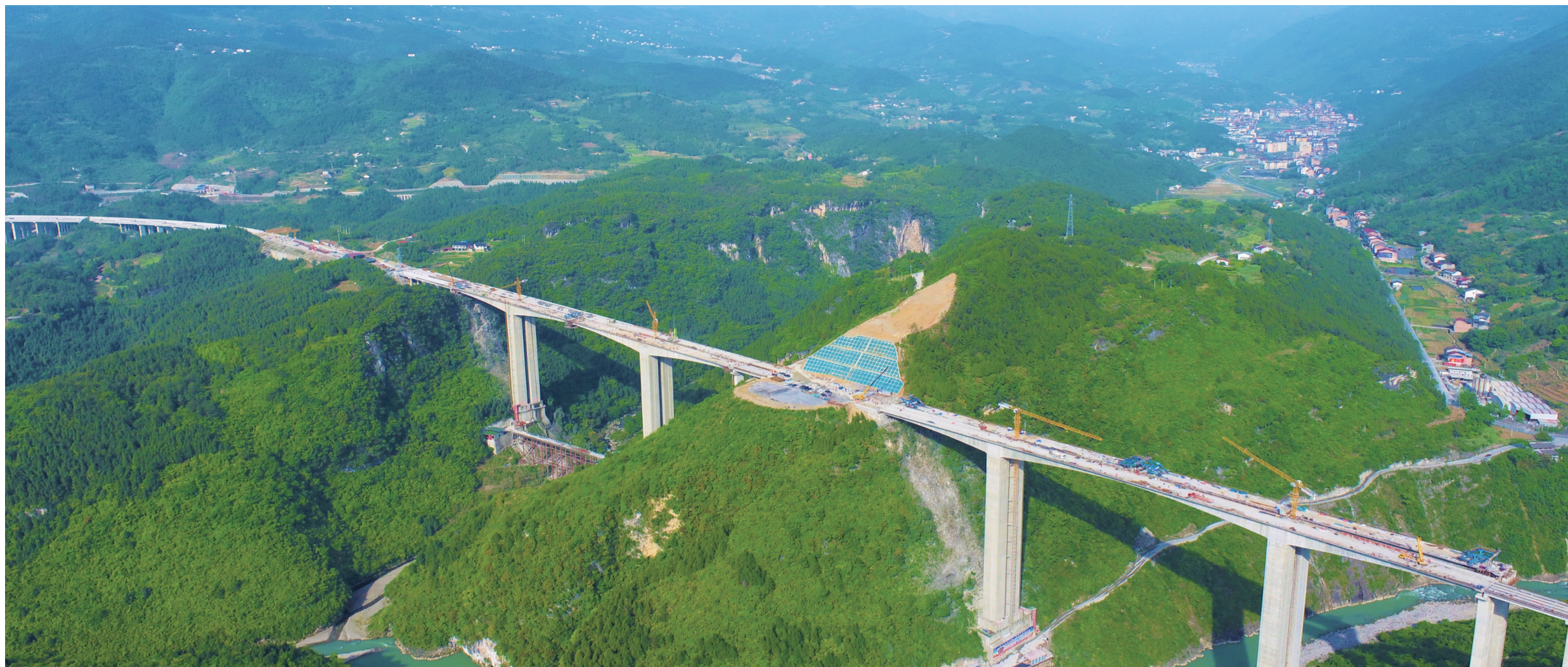
城开高速公路南长沟大桥日前顺利合龙
