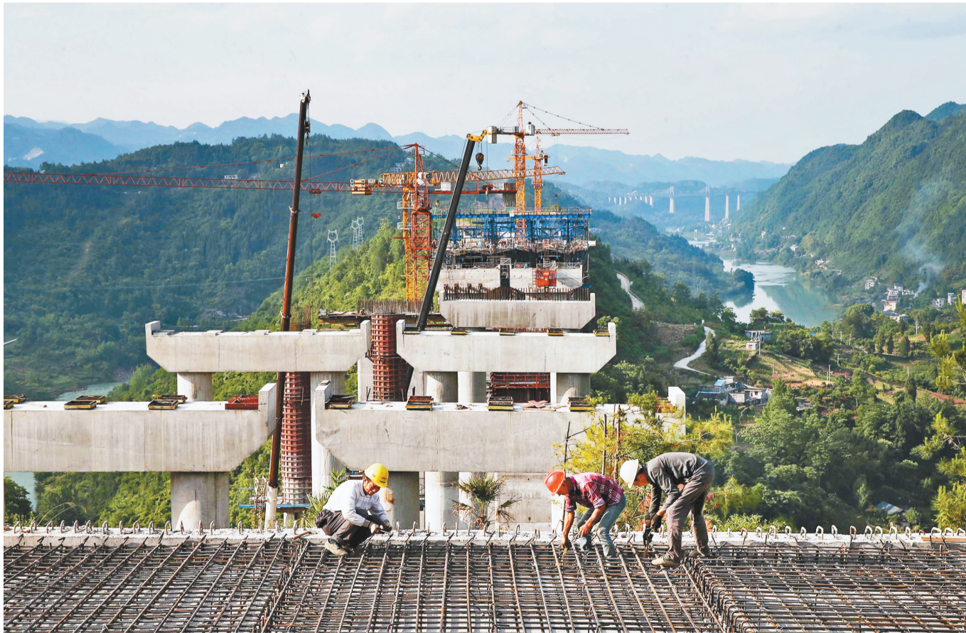
黔江过境高速公路 加紧施工
