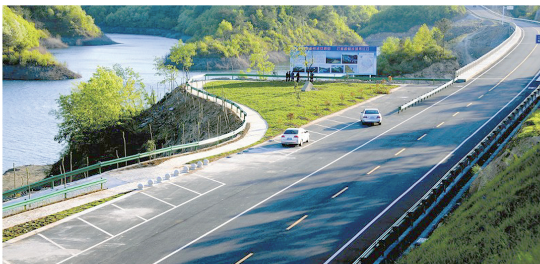
龙角至泥溪产业园公路
