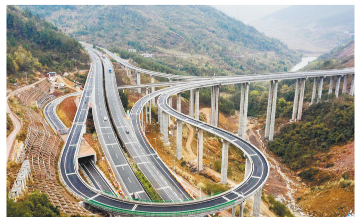
G42沪蓉高速云阳东互通立交工程正式通车。(摄于2021年3月8日) 通讯员 刘兴敏 摄/视觉重庆
