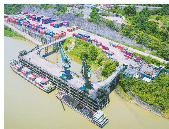
位于永川区朱沱镇的永川港理文码头。
