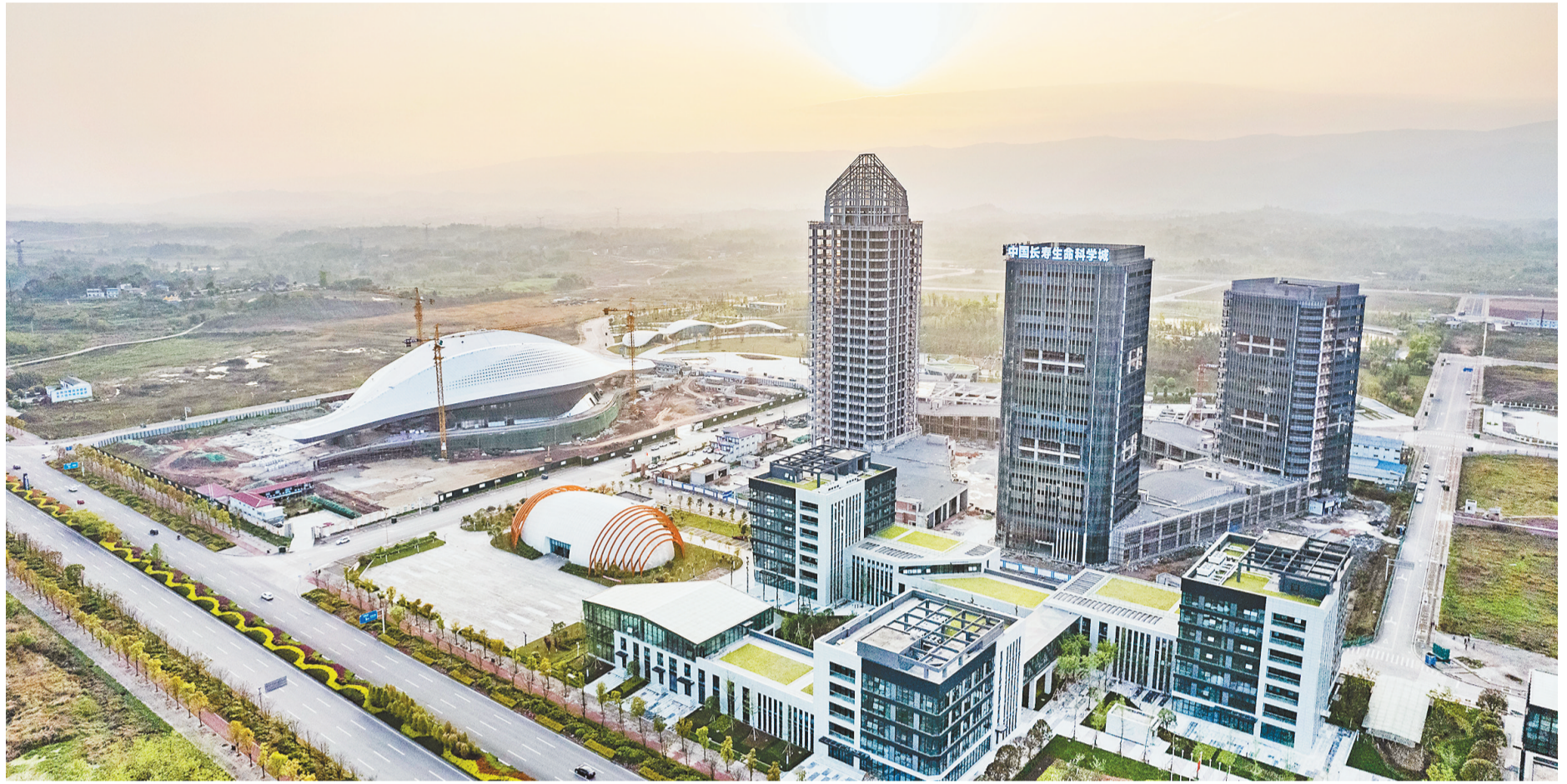
三月二十三日,建设中的长寿区中科未来城创新产业园。记者 谢智强 摄/视觉重庆
