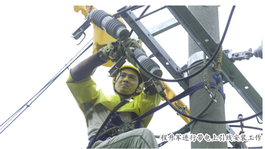
程升军进行带电引流线安装工作
